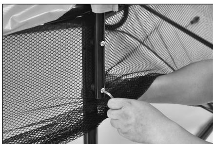
18. Enfin avec les écrous à embase (Q) et à l'aide des clés (E et F), vissez le montant sur le pied au niveau les deux point de fixation. Répétez l'opération pour les autres montants
